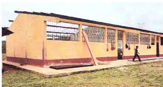
Foto 2: Rehabilitación de la estructura del entechado de la escuela.
