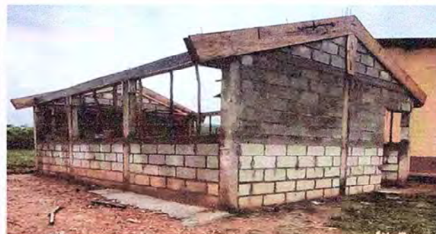
Foto 6: Proceso de colocación de la estructura del entechado de la cocina.
