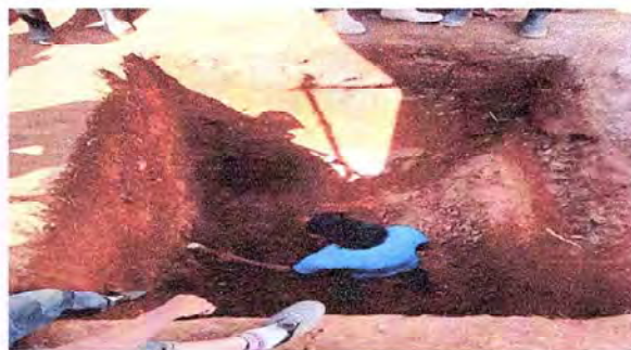
Foto 4: Excavación del área fosa séptica
