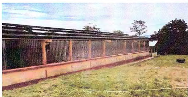
Foto 1: Desinstalacion de la estructura de techo de la escuela.
